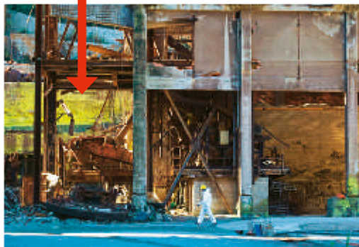
La fabbrica Lo stato dell'impianto industriale, che aveva iniziato a produrre nel 1900, all'inizio dei lavori di bonifica.
